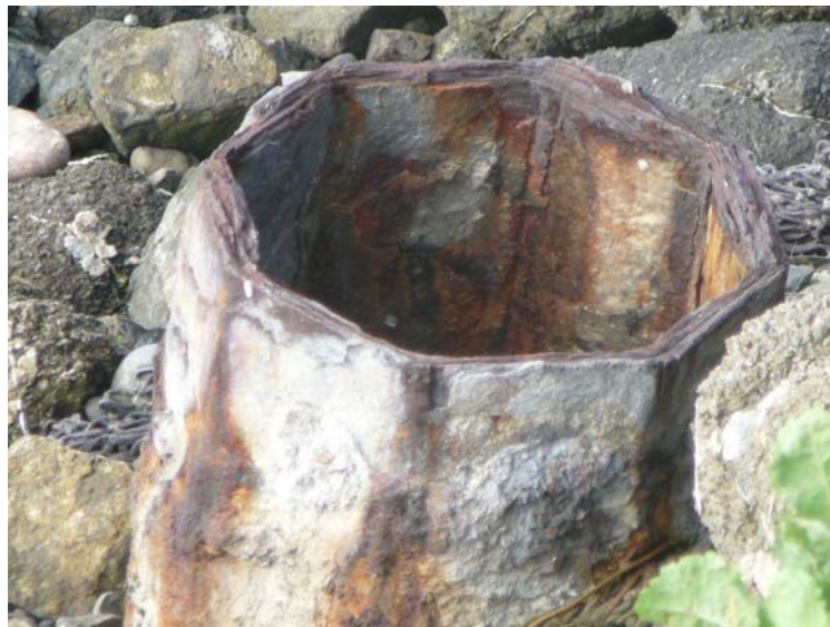
FIGURA 2.3: PILOTE FRODINGHAM No. 4 DE 8 LADOS ENTERRADOS EN LA COSTA DEL MUELLE
