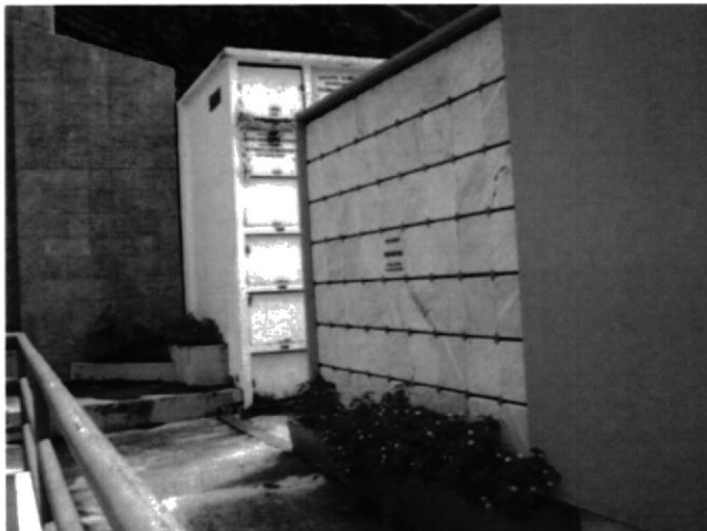
Figura 6-3 Nichos cinerarios en bloque
