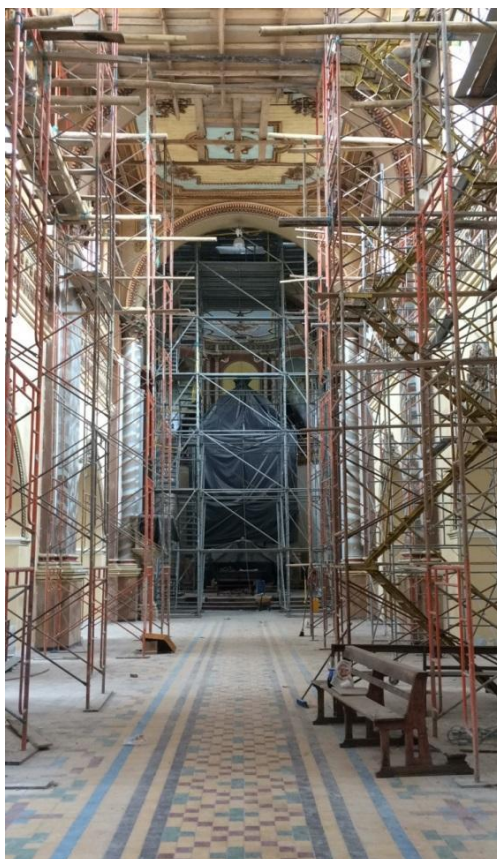
Figura 30 Trabajos de restauración y remodelación de la Iglesia de San Blas desde la Nave Central de la Iglesia.
