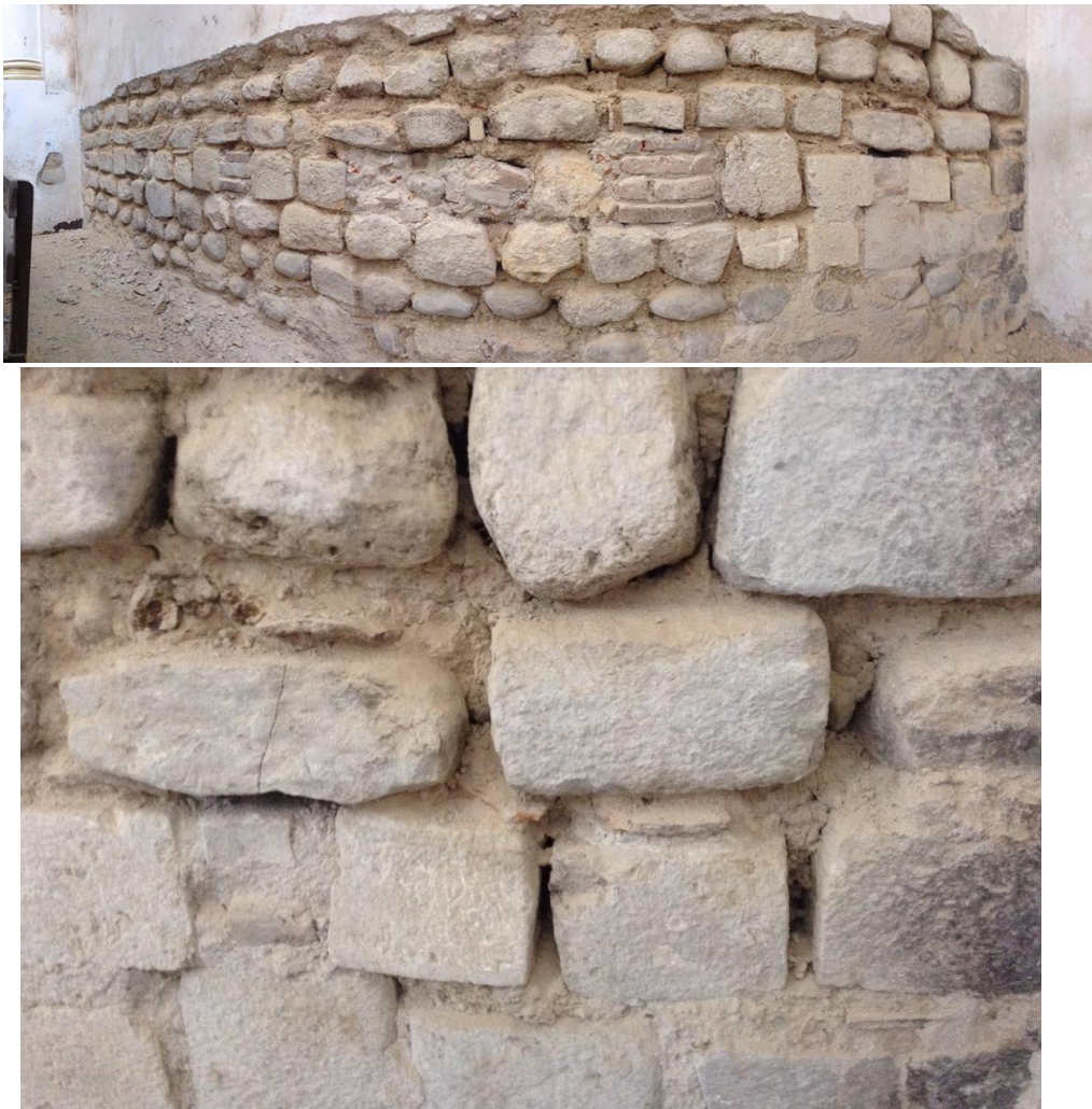
Figura 6 Transepto Norte, interior de la iglesia de San Blas, sistema constructivo con el empleo de los sillares inkas, posiblemente pertenecientes a Pumapungu.
