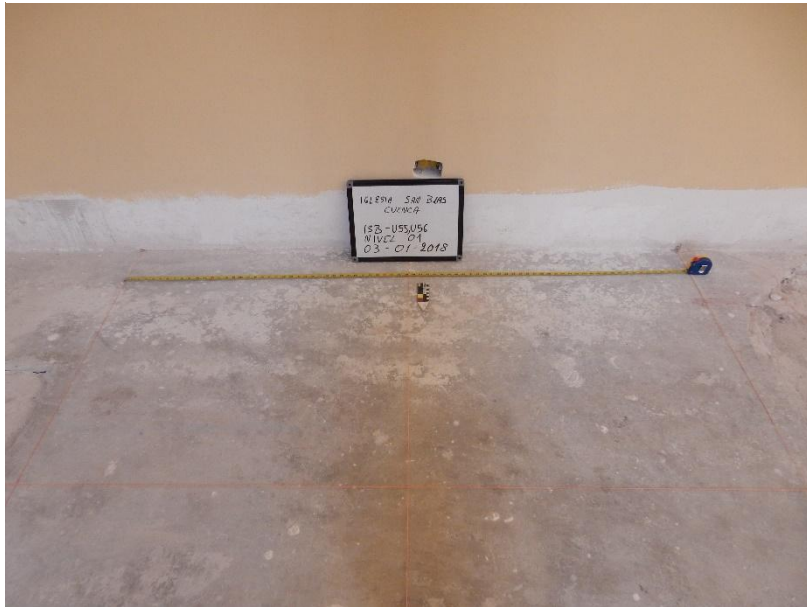
Figura 86 Vista frontal de la superficie en hormigón de las unidades ISB-U55 e ISB-U56.
