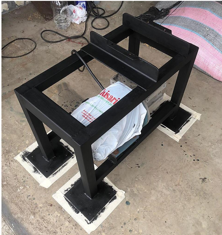
Figura 4.10 Pintado con anticorrosivo color negro
