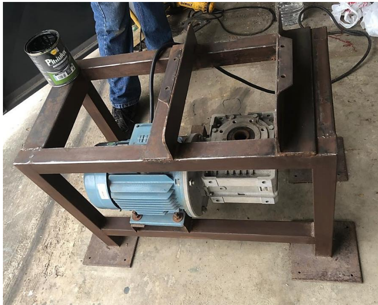
Figura 4.9 Lijado y limpieza de superficie
