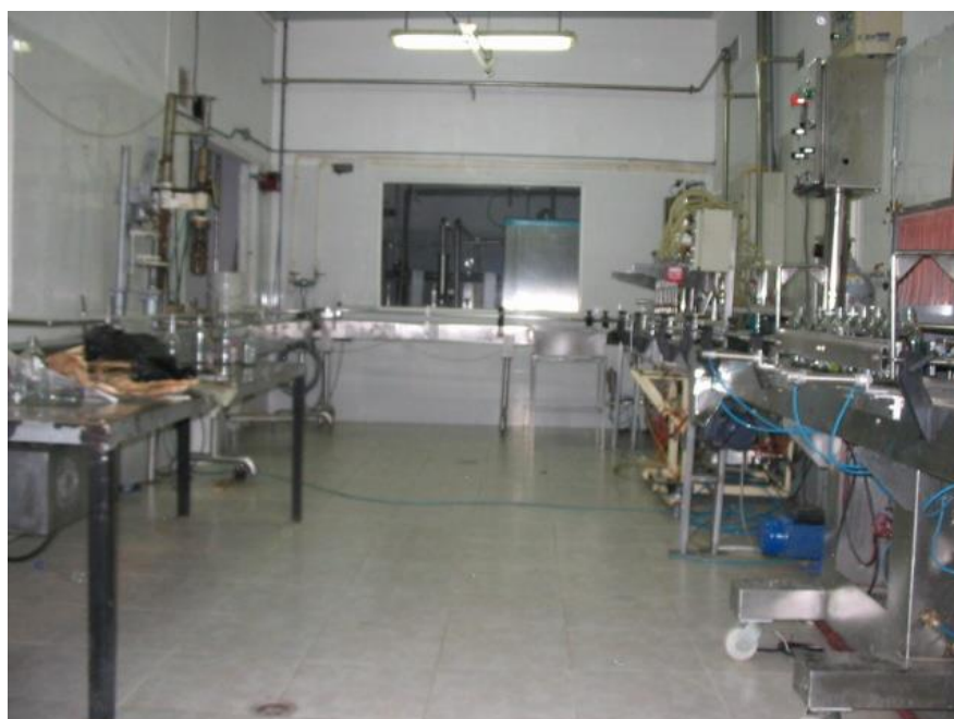
FIG. 2.6 EQUIPOS COLOCADOS EN LA SALA DE LLENADO EN FORMA DE UNA LETRA U.
