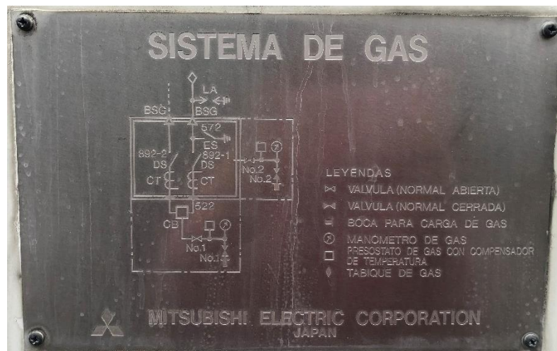
Figura 1-8: Placa del sistema de seccionadores y gas.
