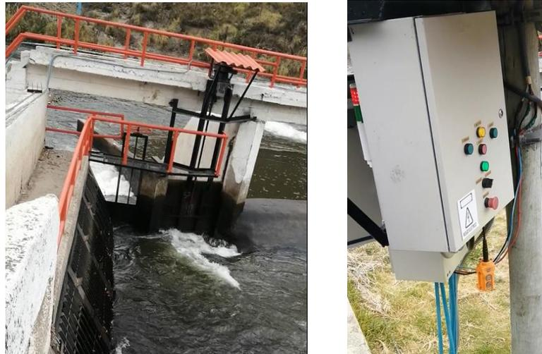
**Figura 4-2 Montaje e instalación de los equipos en la compuerta 5**
