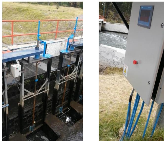
**Figura 4-3 Montaje e instalación de los equipos en la compuerta 1 y 2**
