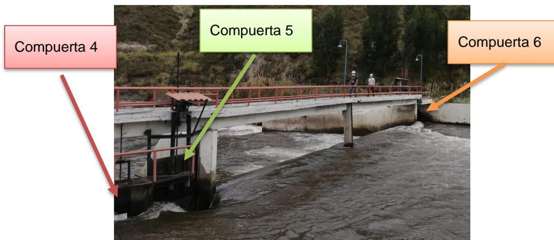
**Figura 3-2 Compuerta 3,4,5 de la bocatoma**
