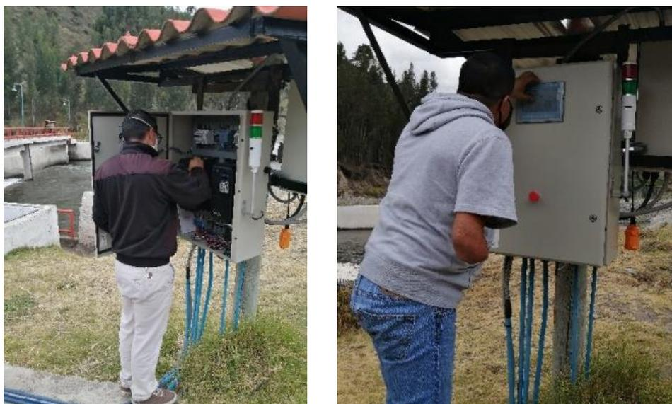
**Figura 4-6 Verificación de programación pantalla HMI y funcionamiento de compuertas 1 y 2**
