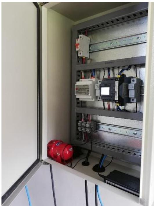
**Figura 3-10 Tablero de control en la cabina del operario**
