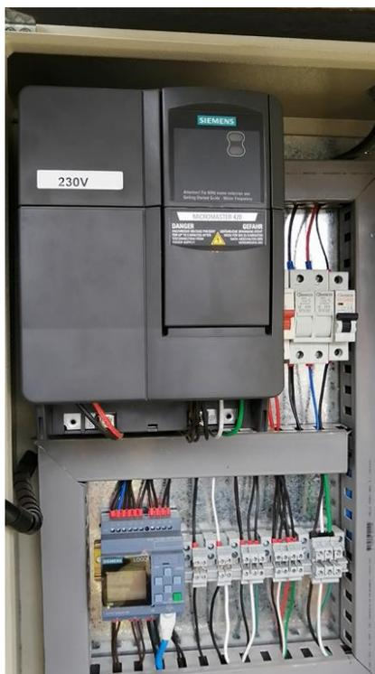
**Figura 3-12 Tablero de control para la compuerta 5**
