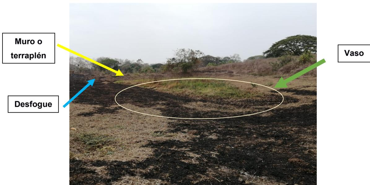
**Figura 2.1** Visualización actual del muro o terraplén, el vaso de la albarrada y el área de desfogue [Creado por el autor]
