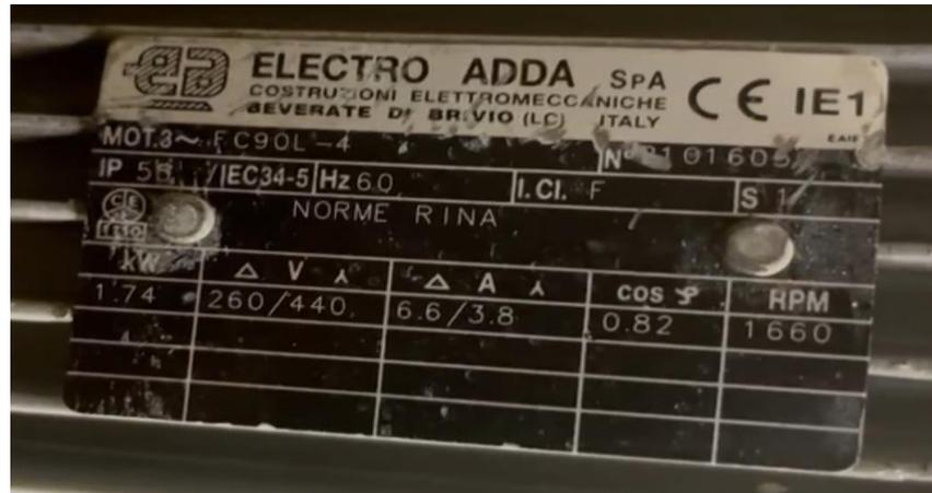
Figura 4.44 Datos de placa del motor (bomba de achique) [3]
