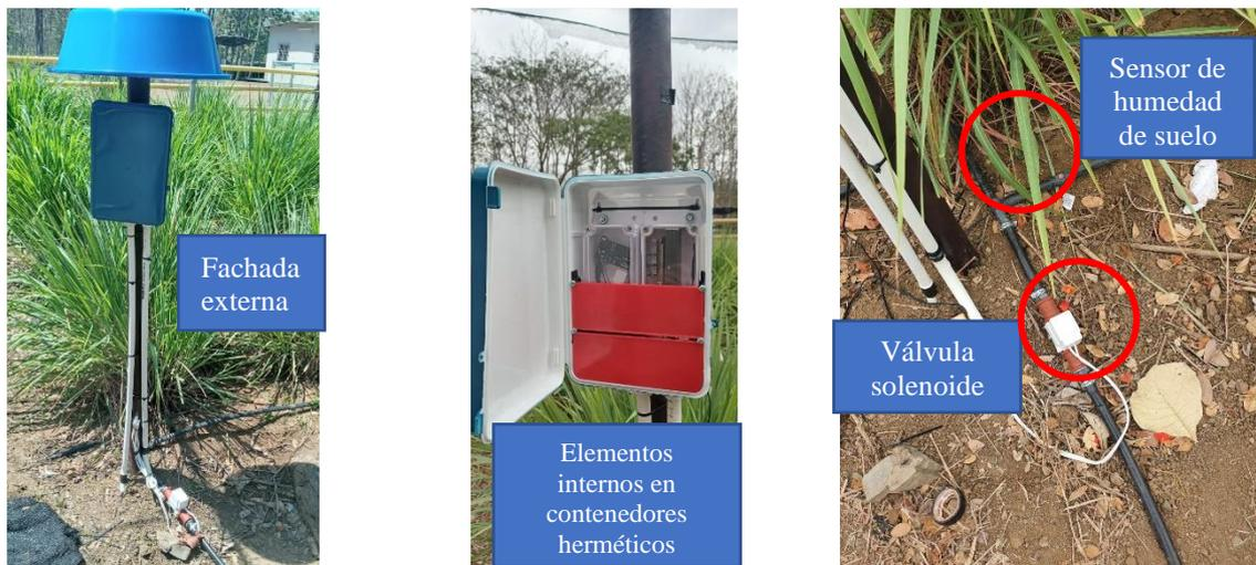
**Ilustración 4.15: Implementación del prototipo de riego inteligente**
