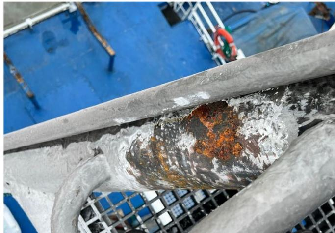
**Figura 3.11 Corrosión detectada en la estructura de soporte del mástil.**
