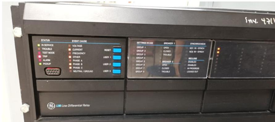
Figura 3.12 Disparo de relé L90 ante la presencia de una falla.
