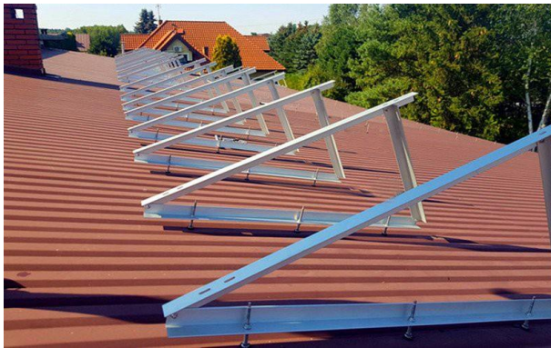
Figura 2.3 Soporte triangular para paneles solares [33]
