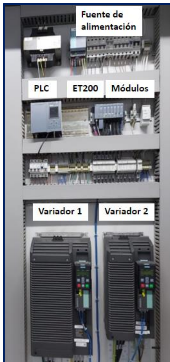
Figura 23 Panel de control perteneciente al área de spray y envasado (A2X-PCA4)
