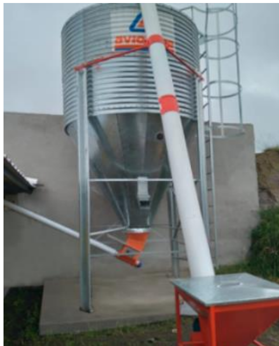
Figura 2.8 Silo con dosificador de tornillo [20]
