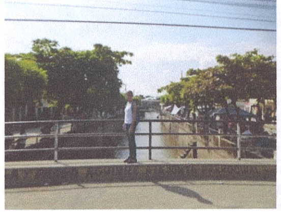
Ilustración 3: Puente vehicular sobre el estero Guachapelí
