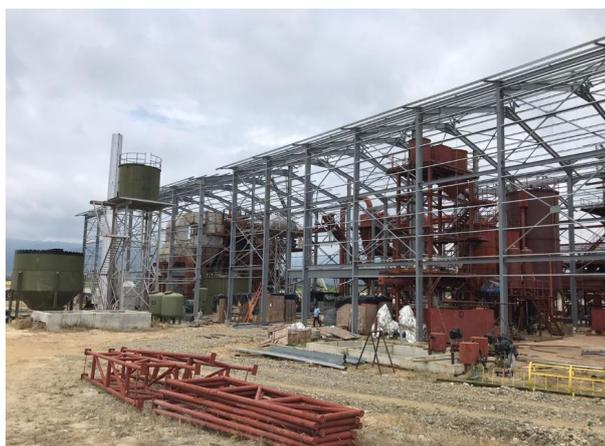
Figura 3.2: Planta extractora en proceso de constructivo.
