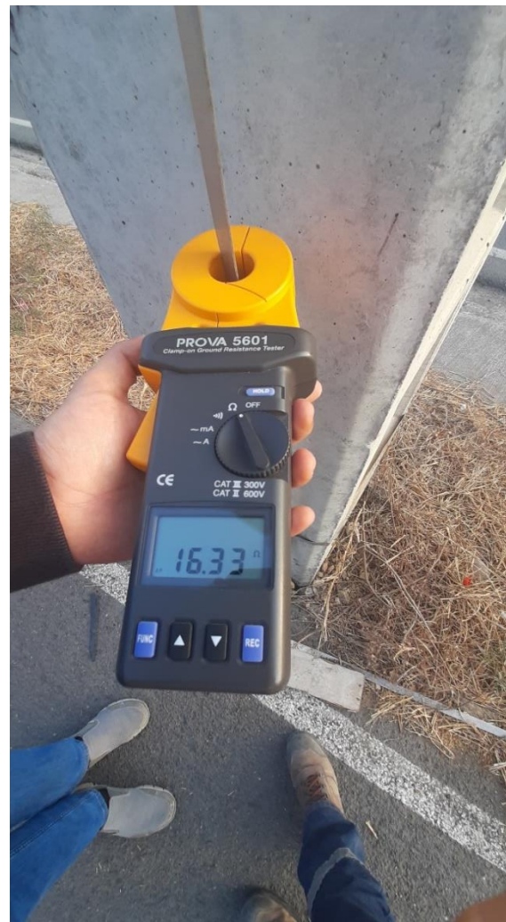
Imagen 19. Medida registrada el 24 de noviembre del año 2020 en sistema de puesta a tierra de acero inoxidable instalado en Vía a la Costa en Guayaquil
