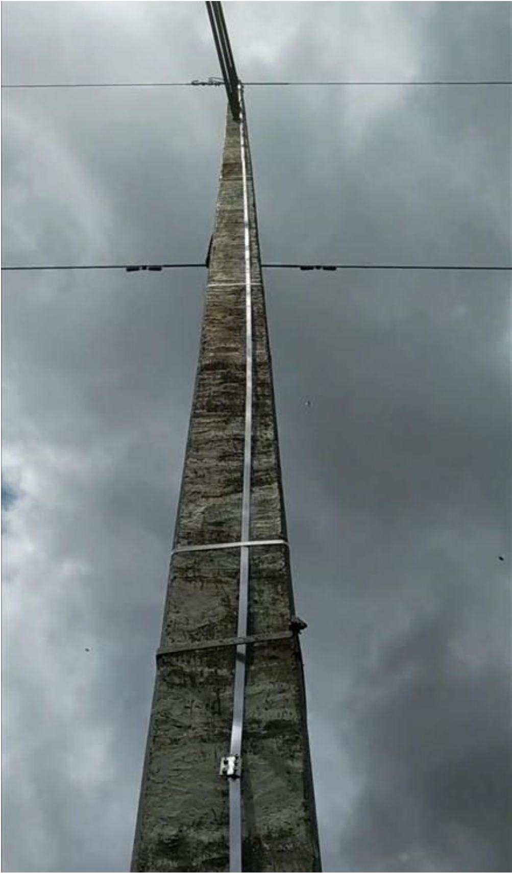
Instalación de SPT de acero inoxidable de estructura de transmisión vía Santa Elena, parte 1
