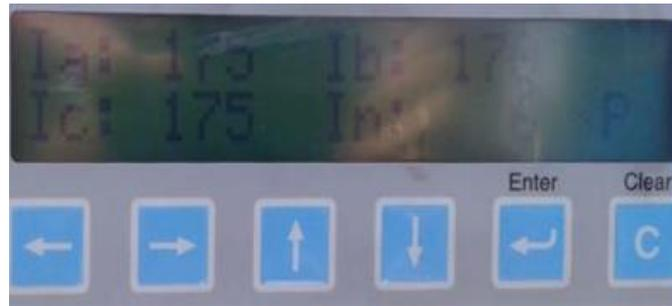
En la Figura 2.2 se observa el valor de corriente en el alimentador para la línea Ia, Ib, Ic 175 A, 170 A, 175 A respectivamente. Al calcular la corriente de demanda máxima de 193,8561 A en el alimentador ESPOL.
