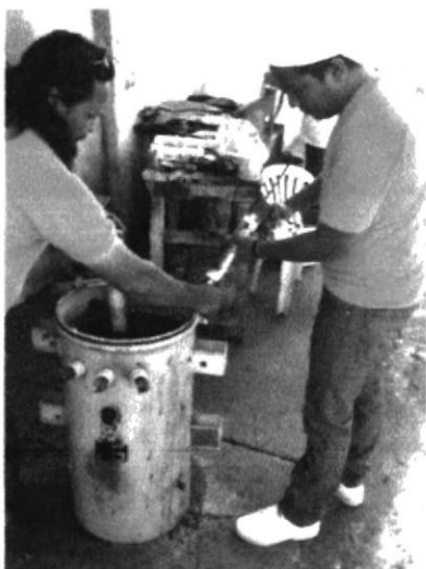
Fig. #28 Silicón para sellar Transformador
