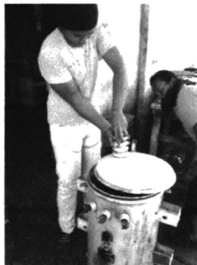
Fig. #29 Sellado del Transformador
