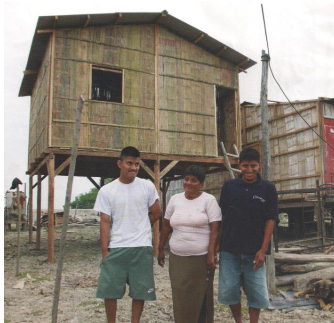
Imagen 3-21: Casa Modulada de 4.80x4.90mts. Base de puntales de madera.
