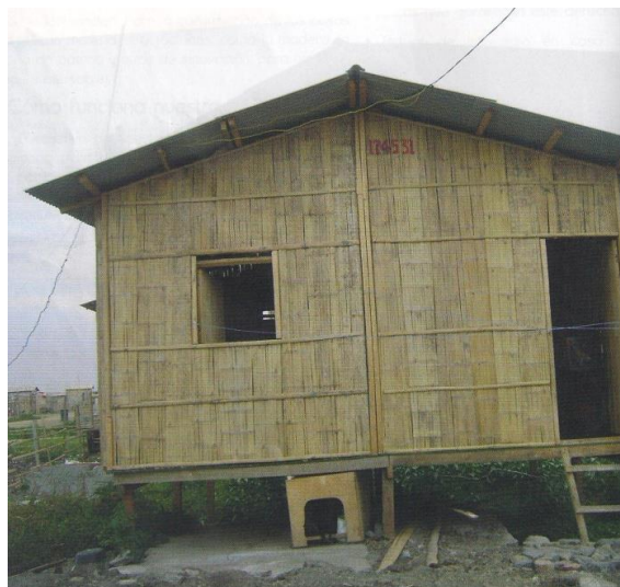
Imagen 3-22: Casa modulada de 4.80x4.80mts. Base de puntales de madera.
