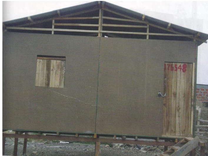
Imagen 3-23: Casa modulada de 4.80x4.80mts. Base de puntales de madera, paredes y pisos de Novopan.
