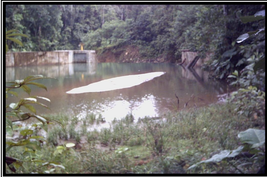
Fotografía 3. Vista de la acumulación de sedimentos en la zona del embalse
