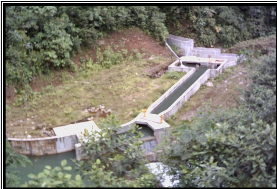
Fotografía 4. Obras de toma para el sistema de agua potable del cantón Pedro Vicente Maldonado
