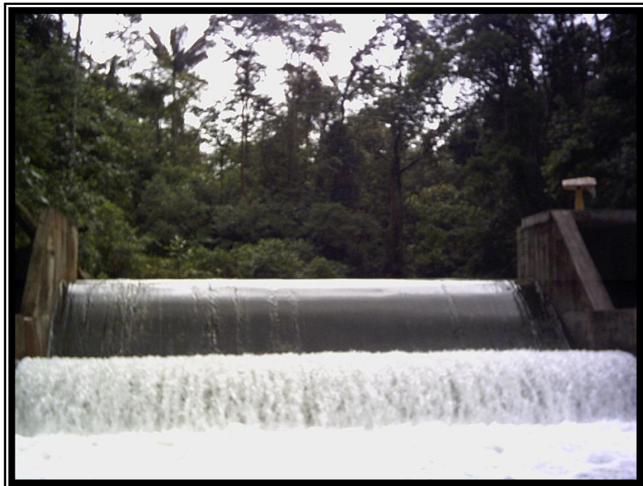
Fotografía 6. Vista del vertedero del sistema de agua potable
