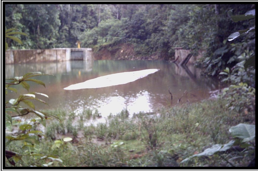
Fotografía 5. Vista de la acumulación de sedimentos en la zona del embalse
