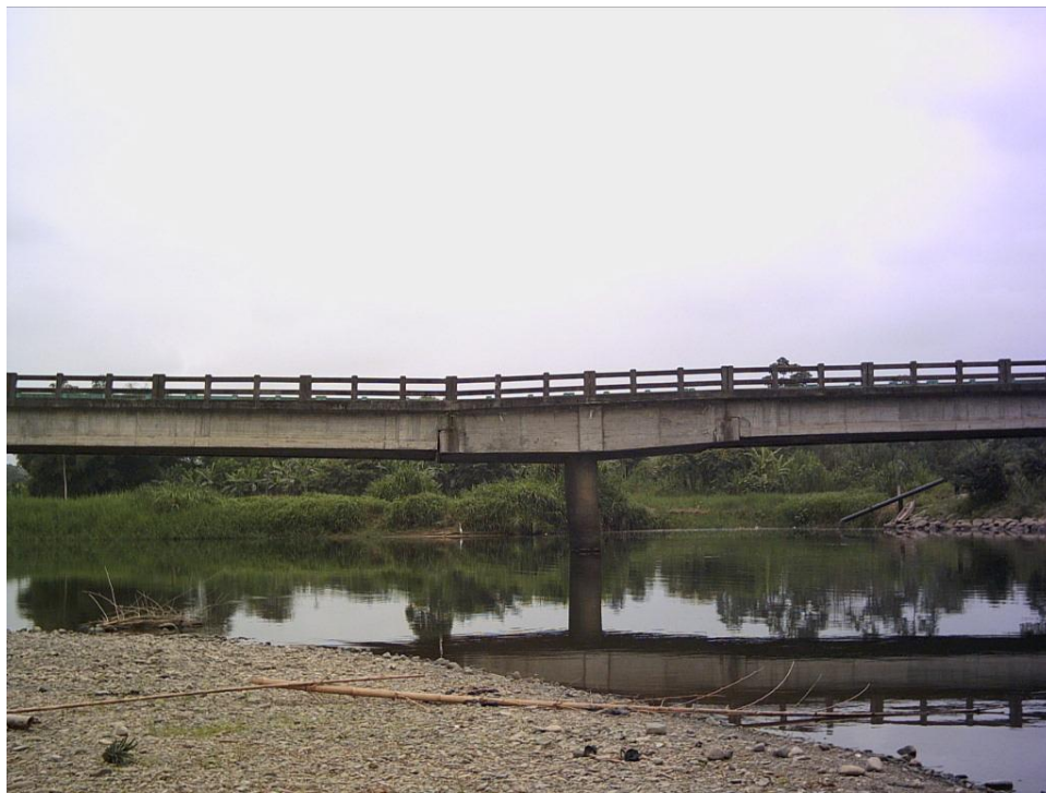
Vista lateral del Puente actual “Los Camarones”.
