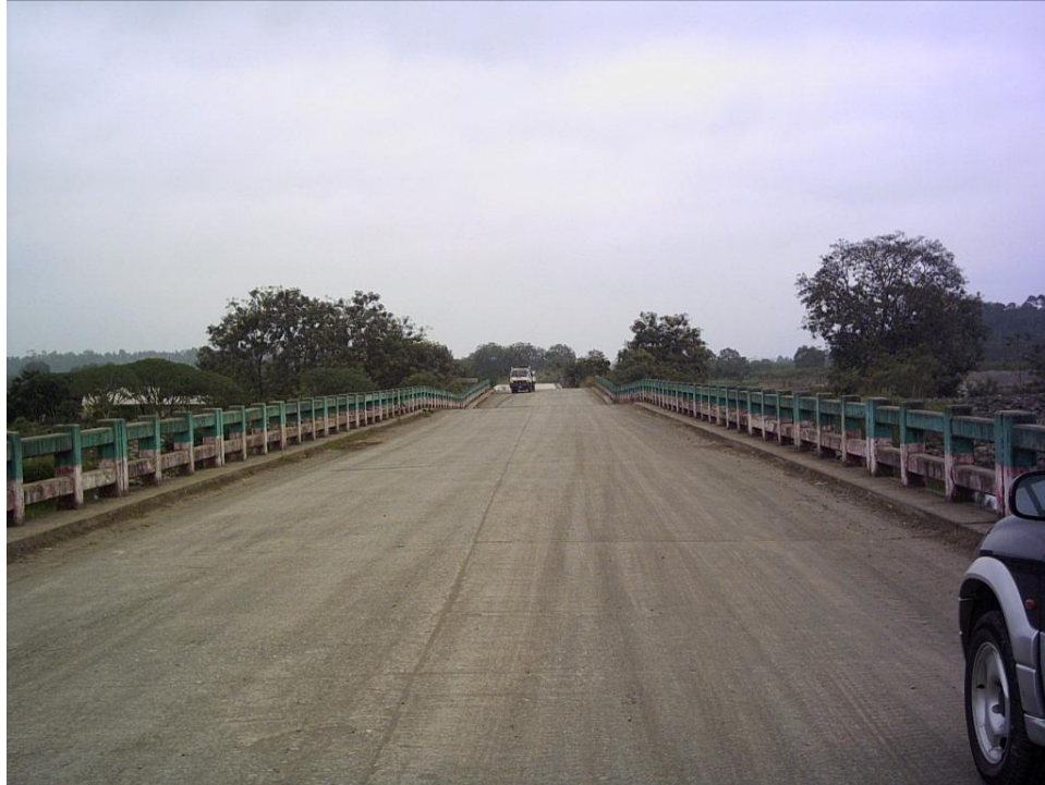
Vista del actual Puente “Los Camarones”.
