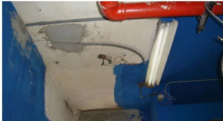
Fig. 5.9 Área de cocina del hospital de SOLCA
