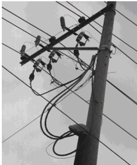
Fig. 1.7 Acometida principal del hospital de SOLCA
