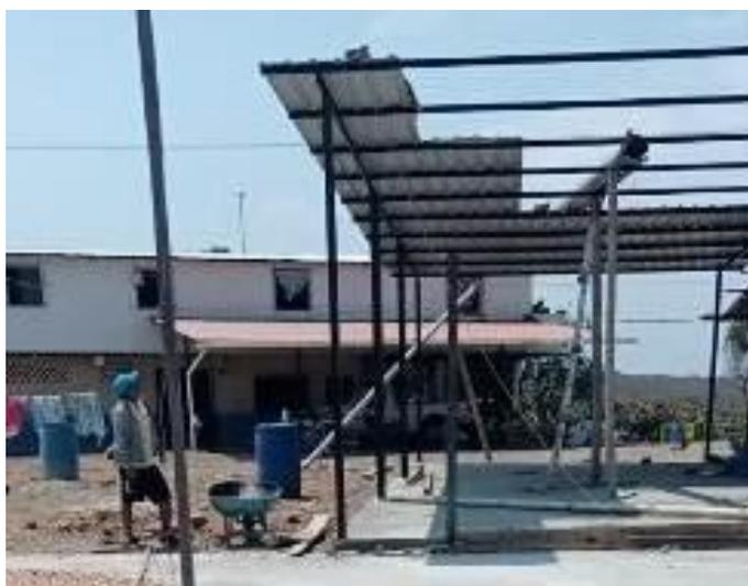
**Figura 3.6 Construcción área para secador en finca 1**
