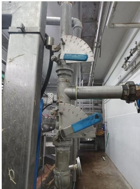
**Figura 2.15 Evidencia fotográfica de las instalaciones de escalas de medición en tuberías**
