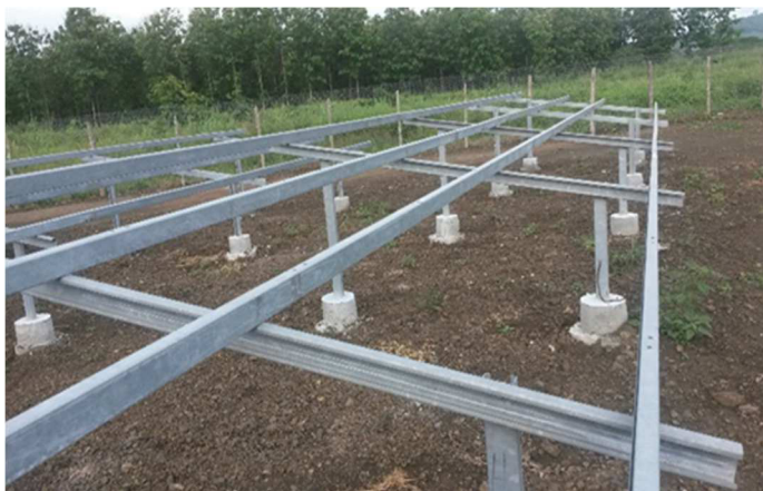
Figura. 3.27 Estructura con Inclinación 10° En La Planta Brineforcorp
