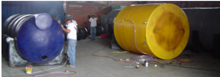
FIGURA 2.3 FOTO DE SOLDADURA
