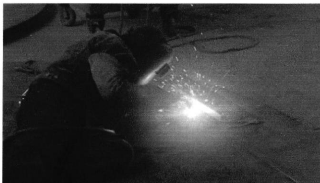
Figura 4.14 Opción Inspección en Soldadura
