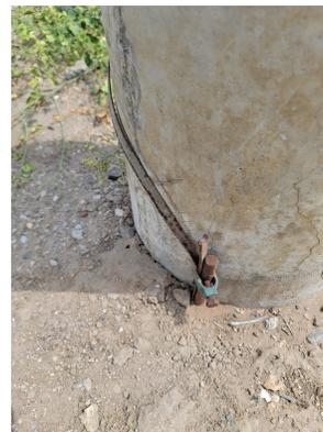
(b) Conductor con oxidación
