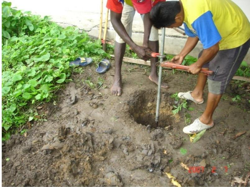
**FIGURA 4.37. PERFORACIÓN POR MEDIO DE ROTO PERCUSIÓN**
