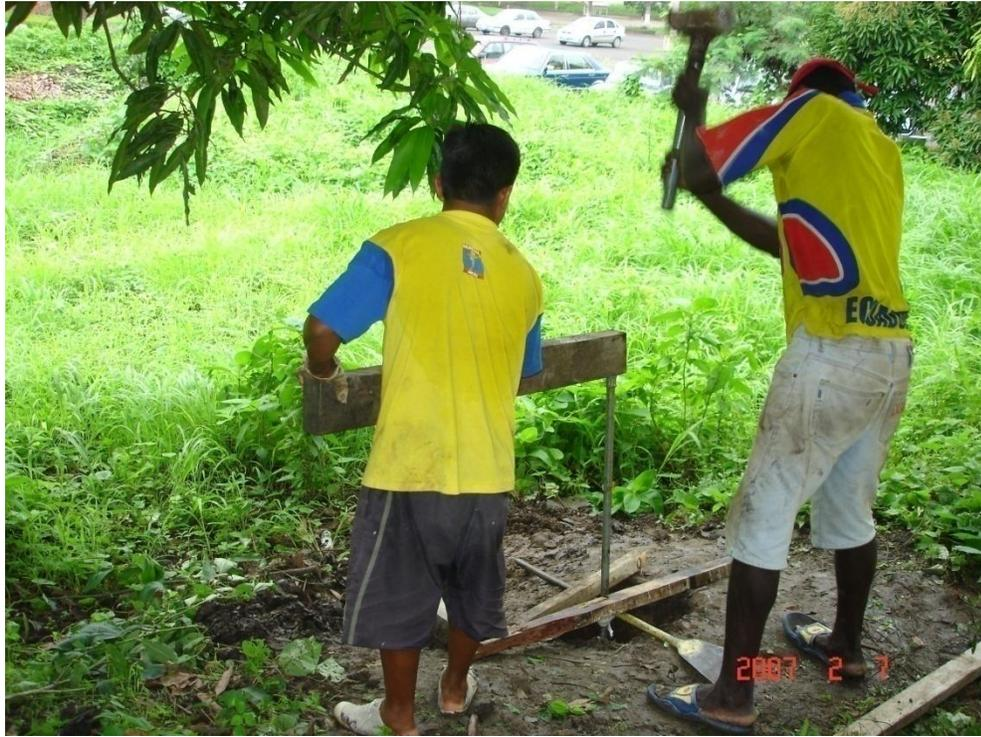
**FIGURA 4.42. PERFORACIÓN POR MEDIO DE ROTO PERCUSIÓN**
