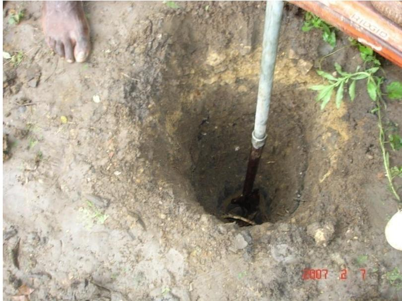
**FIGURA 4.38. PERFORACIÓN POR MEDIO DE ROTO PERCUSIÓN**
