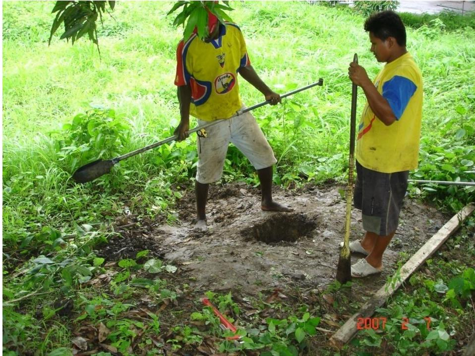
**FIGURA 4.40. PERFORACIÓN POR MEDIO DE ROTO PERCUSIÓN**
