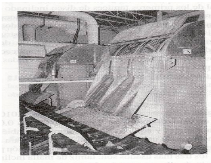
Figura 3.7. Fotografía de un tamiz de disco rotatorio con orificio de 250 \mu m usado en reemplazo de un sedimentador primario.
