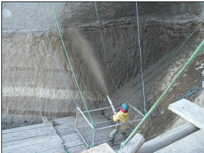
**FOTO 12. ESTABILIZACIÓN DE PAREDES MEDIANTE GUNITADO**
