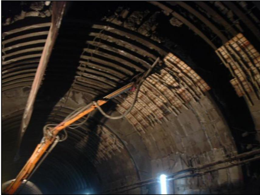
**FOTO 9. GUNITADO DE PAREDES DEL TUNEL VIAL**
