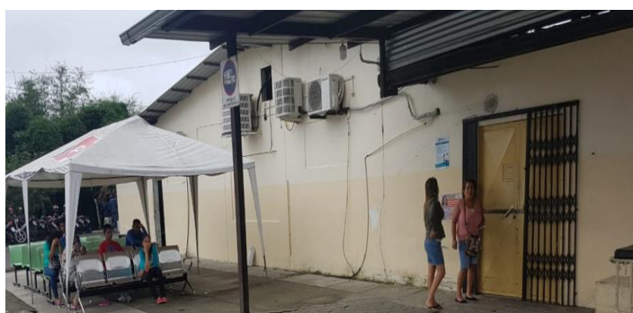
Figura 8 Sala de espera de emergencia
