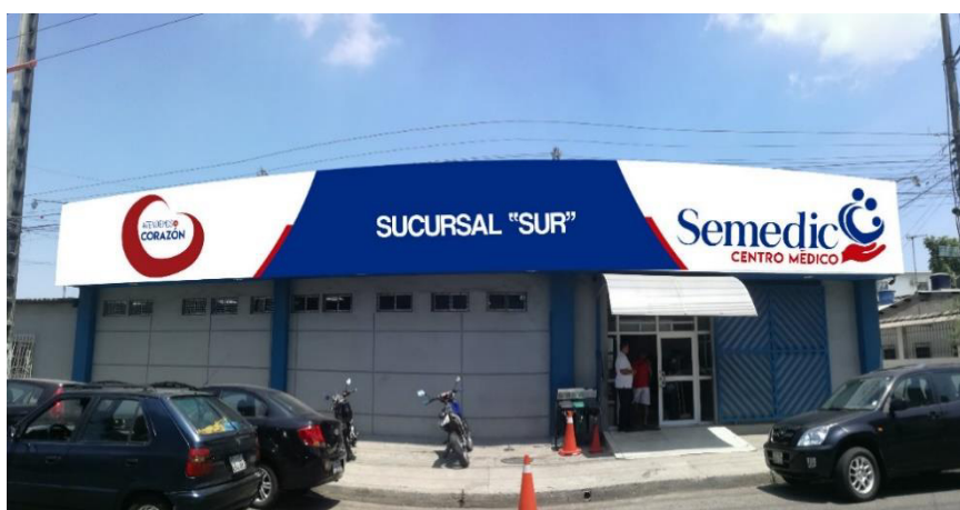
FIGURA 5. Edificio Semedic Sur
