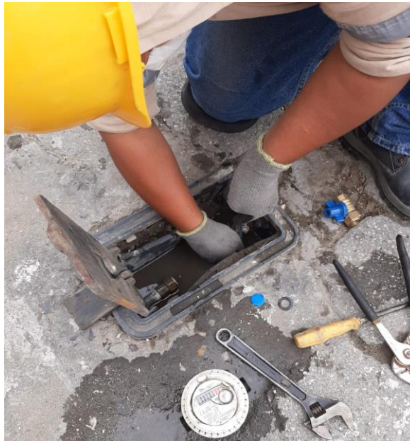
Figura 26: Mantenimiento de Medidores
