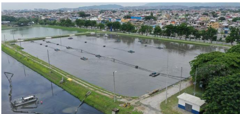
Figura 12: Laguna de tratamiento de aguas servidas
