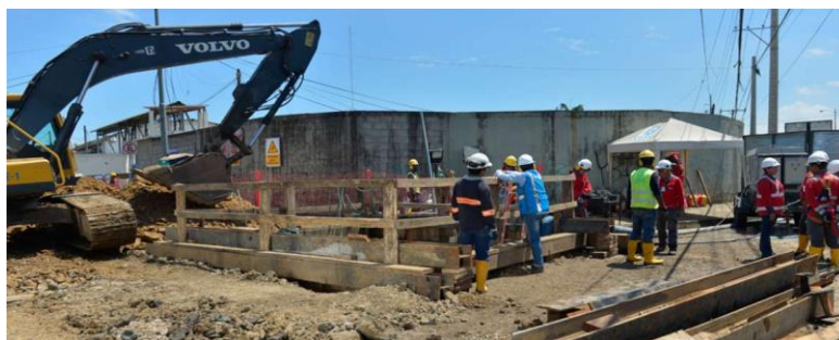
Figura 10: Trabajo de rehabilitación de red de agua potable
