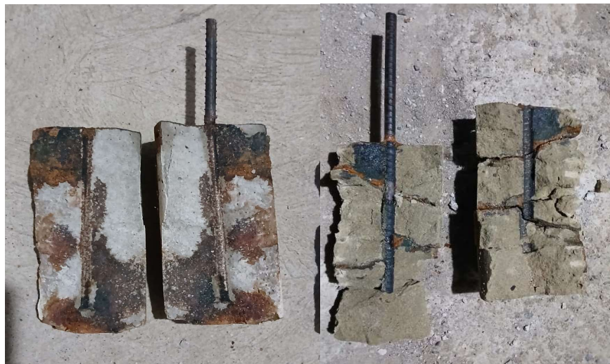
Figura 19 Corrosión en barra de Acero
