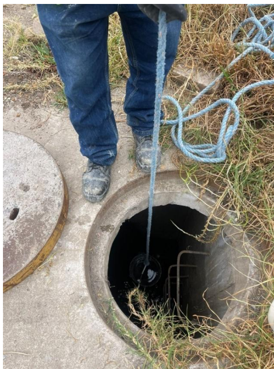
Ilustración 2.10. Punto de obtención de muestra de un pozo de alcantarillado
