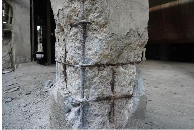
*Ilustración 5. Desprendimiento del Hormigón\_Fuente: Molins.*
