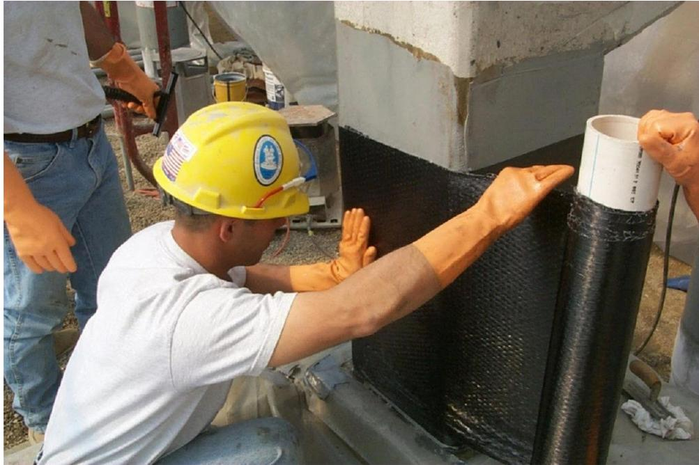
***Ilustración 20\_ Rehabilitación con Fibra de Carbono\_Fuente: Sika Perú.***
