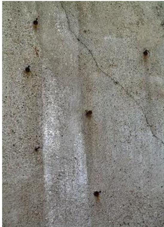
*Ilustración 3. Fisuras en Columnas de Hormigón\_Fuente: Pascal L.*
