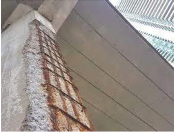
**Ilustración 6. Corrosión en barras de acero\_ Fuente: COTECNO**
