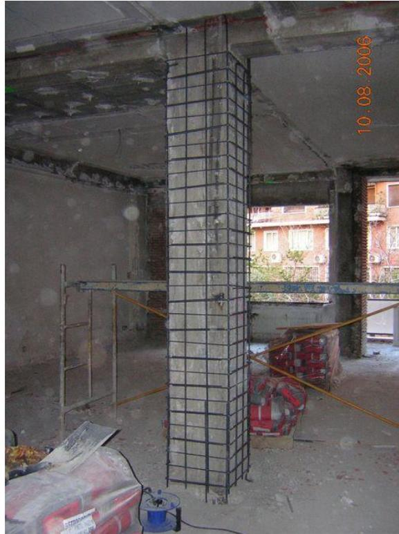
***Ilustración 19\_ Rehabilitación con Encamisado***
