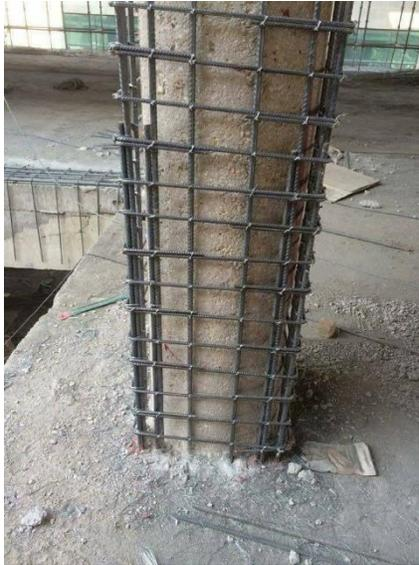
***Ilustración 8. Encamisado de Columnas con Acero\_Fuente: Obras Civiles y Construcción***
