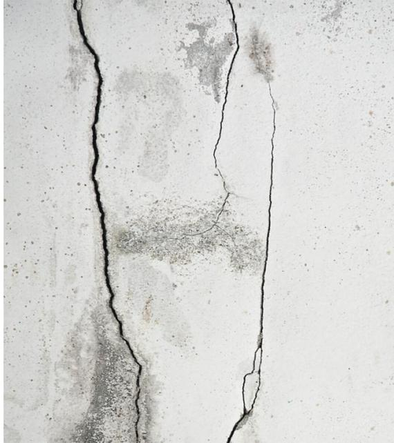
***Ilustración 4. Grieta en Columna de Hormigón\_ Fuente: CEMIX México SA de CV.***
