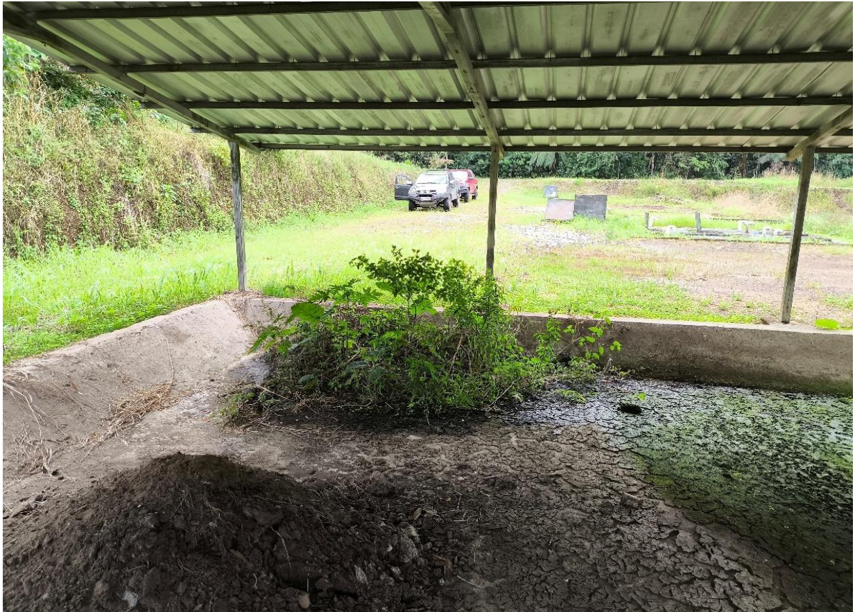
Figura 15. Fotografía de vegetación proliferando en el lecho de secado de lodos.
