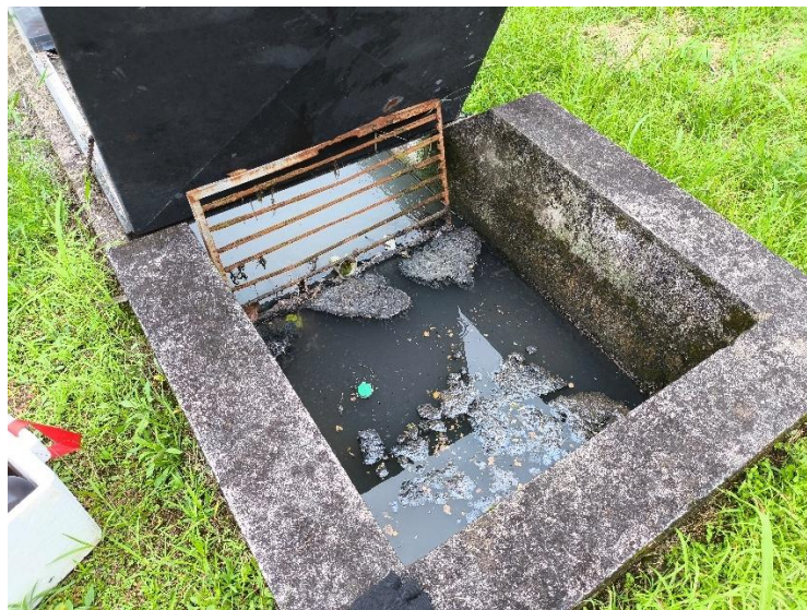
Figura 8. Fotografía de cribas con deformaciones .
