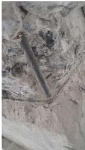
Ilustración 8 Armadura de acero (Alexis Javier Jama Zambrano, 2023)
