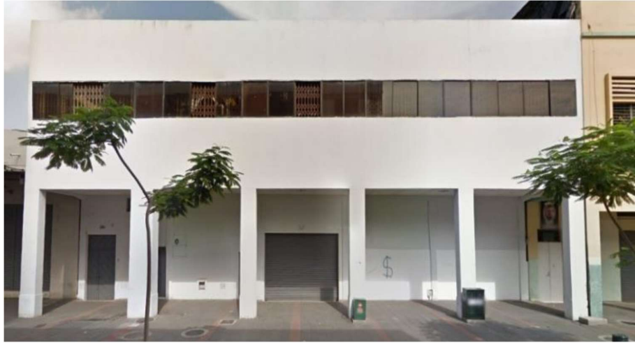
Ilustración 3 Fotografía de fachada frontal del edificio (Alexis Javier Jama Zambrano, 2023)
