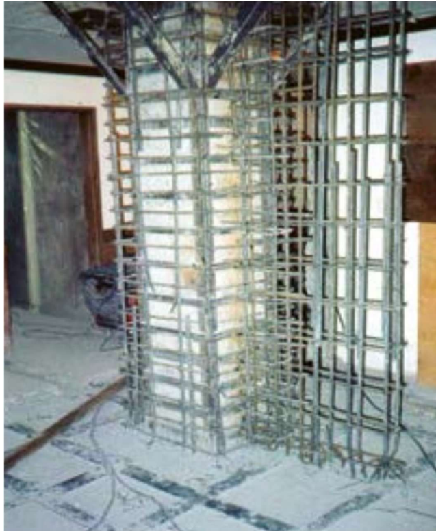
Ilustración 14 Encamisado de columna de concreto (Sika)
