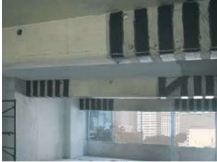
Ilustración 15 Refuerzo a cortante con láminas CFRP (Sika)
