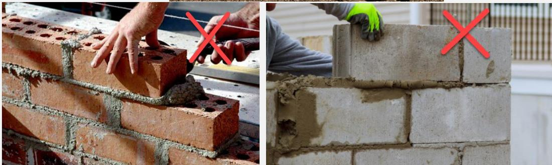
El ladrillo Ecológico **No** requiere de revestimiento o enlucido, se aplica una capa impermeabilizante con el color que se desee, solución ideal para viviendas y cerramientos.
