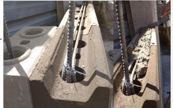
El refuerzo horizontal y vertical permite contruir una estructura sólida sin sobredimensionamientos y reduciendo considerablemente los costos.
