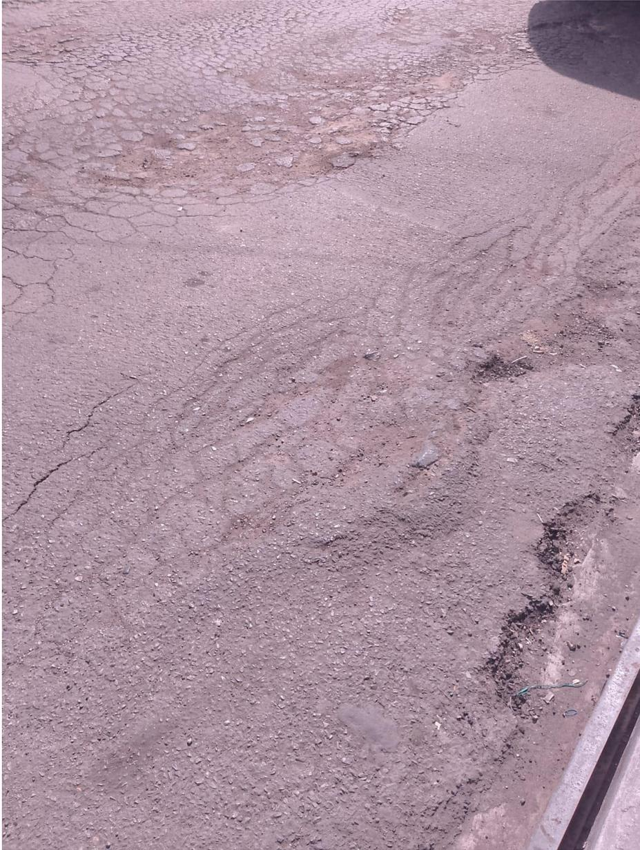
**Ilustración 0.2 visualización de agrietamiento.**
