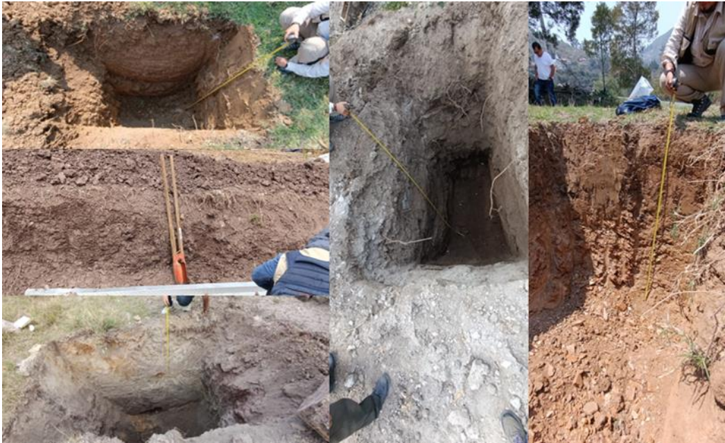
Figura 20 Calicatas para la toma de muestras
