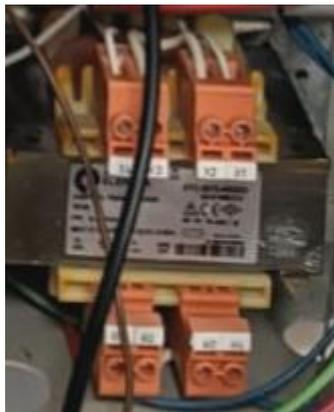
*Ilustración 26. Transformador reductor 220/110 VAC*
