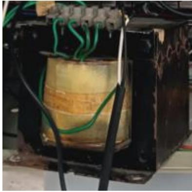
*Ilustración 25. Transformador elevador 220/480 VAC*
