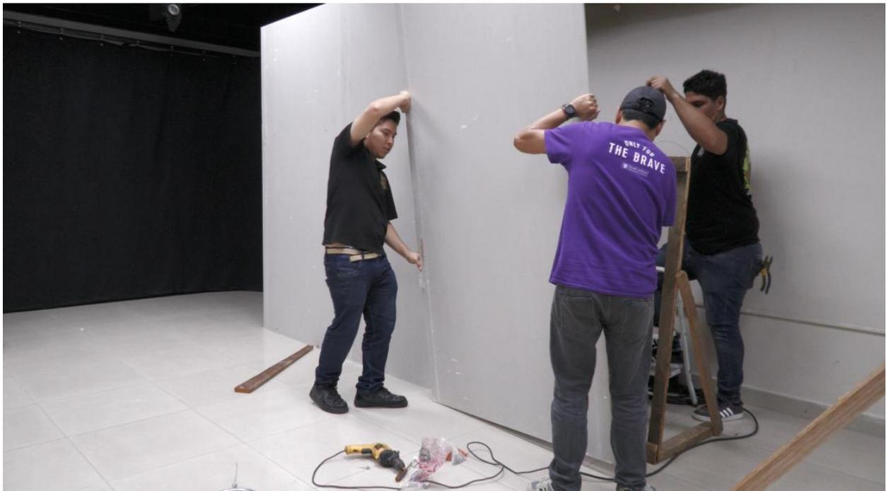
*Nota.* Instalación de paredes de *gypsum*
