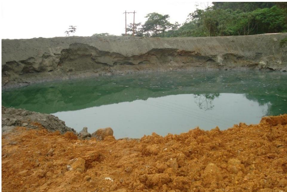
**Figura 5.7** Relavera situada en el sector de La López, la cual tiene protección arcillosa para almacenar colas mineras.
