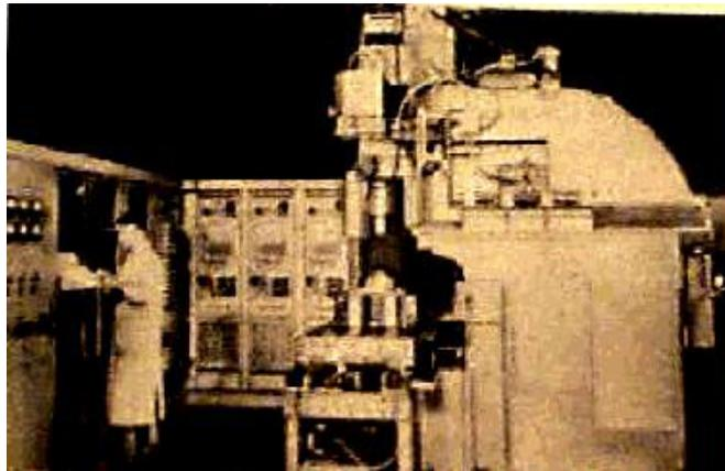
Figura 2.2 Un primer equipo CNC y su sala de control
