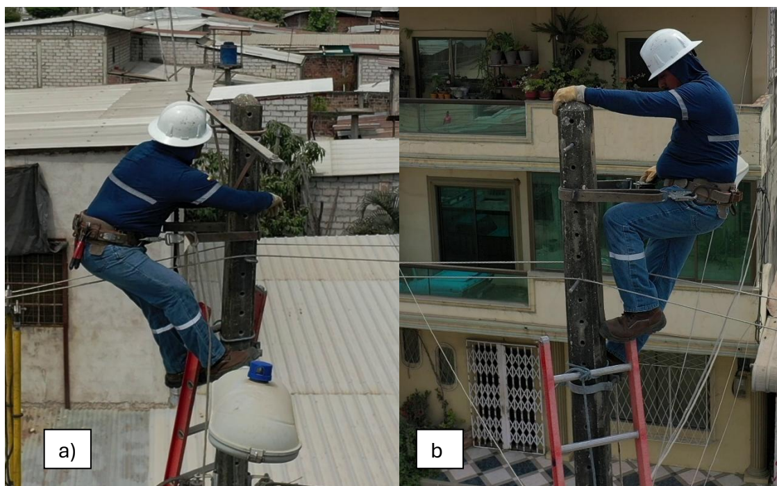
Figura 3.3 Procedimiento de cambio de crucetas y soportes, donde a) Tarea 7. Desmontaje de la cruceta dañada y su descenso; b) Tarea 4. Liberación del aseguramiento de los conductores y su descenso temporal para liberar la cruceta dañada
