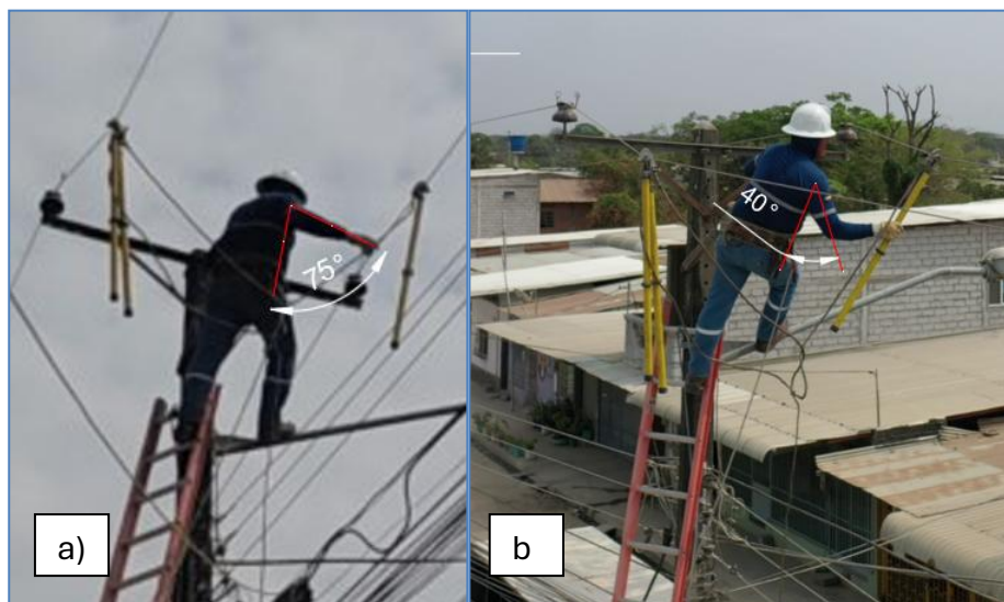
Figura 3.8 Imágenes capturadas mientras se realiza la puesta a tierra temporal a) Con cámara celular desde el nivel del suelo, b) Con dron a la altura del trabajo realizado
