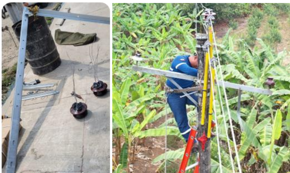
Figura 3.4 Cambio de crucetas y soportes
